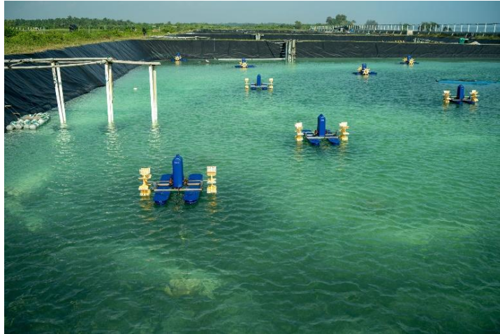
Gambar 1. Aerator Budidaya Tambak Udang
